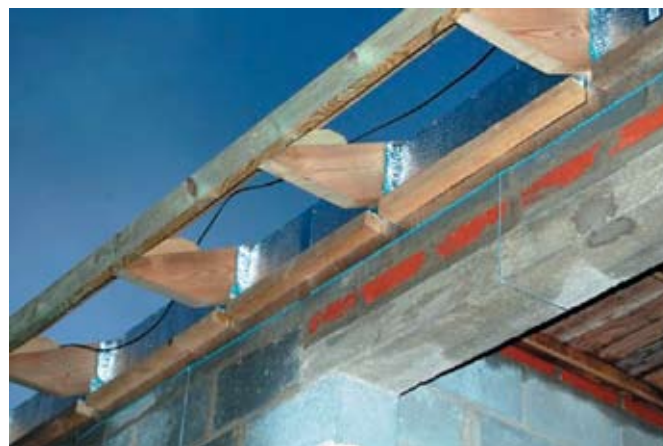
Рис. 4. Применение отражательной теплоизоляции в конструкции скатной кровли
