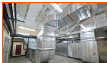
Изоляция воздуховодов
