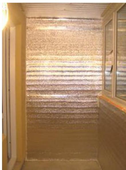
Вторым слоем, поверх Пеноплэкса, устанавливается Пенофол, фольгой внутрь помещения (см. фото). При монтаже Пенофола важно избегать нахлёстов, монтаж в стык – наиболее подходящий вариант. Для полной теплоизоляции необходимо все стыки проклеивать алюминиевым скотчем ЛАС или ЛАМС. Во избежание образования мостиков холода не стыковать Пенофол в местах соединения ограждающих конструкций (стена-пол, стена-потолок, углы).
