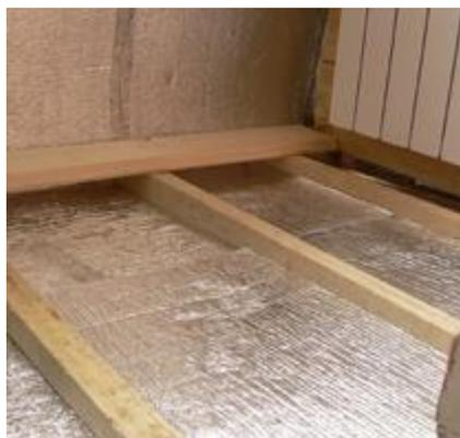
По этой схеме необходимо выполнить утепление боковых стен, парапета, потолка и пола. Однако не всегда есть возможность оставить воздушный зазор между Пенофолом и верхним покрытием пола в теплоизоляционной конструкции нижней плиты перекрытия. В таких случаях Пенофол будет выполнять роль гидроизоляции и равномерного распределителя тепла (в случае устройства кабельного «теплого» пола).
